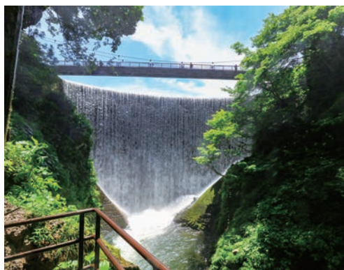
▲大源太川第一号砂防堰堤
