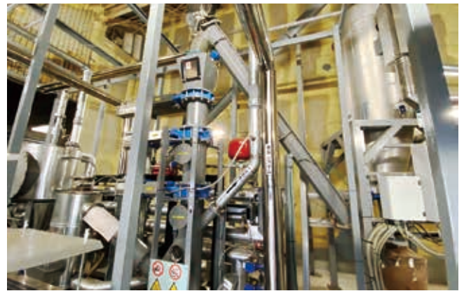
▲林地残材は木質チップボイラー（左）や木質バイオマス発電設備（右下）により熱や電力に生まれ変わって村内へ供給される
