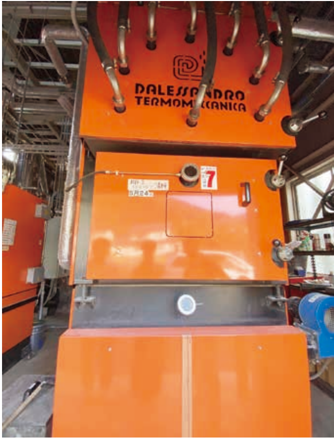
▲林地残材は木質チップボイラー（左）や木質バイオマス発電設備（右下）により熱や電力に生まれ変わって村内へ供給される
