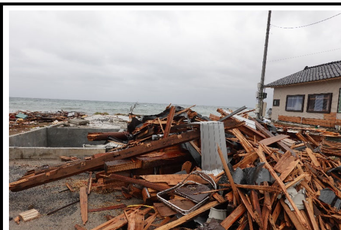
津波被害が発生した白丸地区 1
