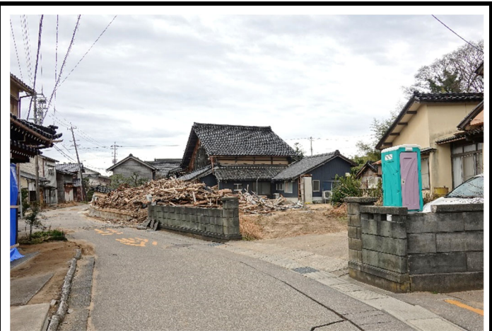
液状化被害を受けた柳瀬地区 2
