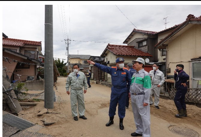
液状化被害を受けた西荒屋地区 2
