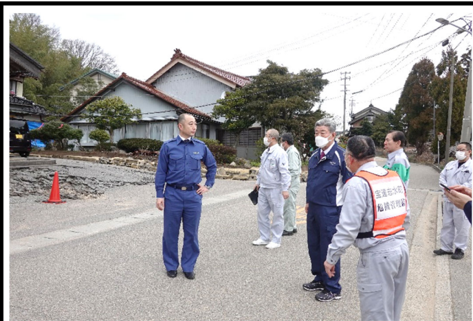
液状化被害を受けた柳瀬地区 1
