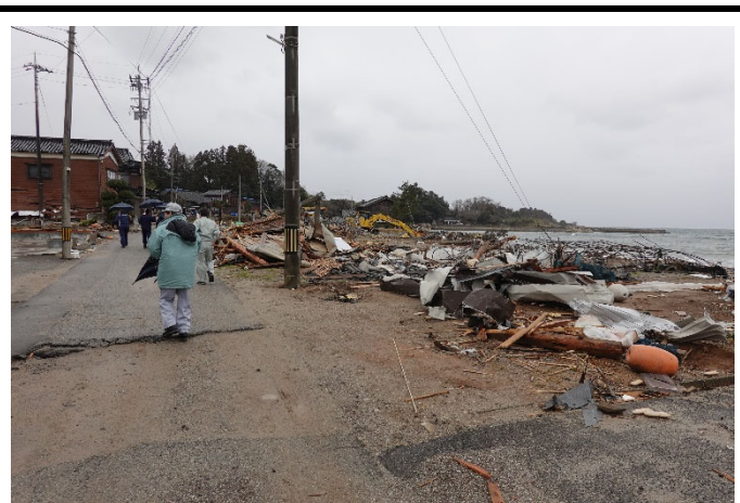
津波被害が発生した白丸地区 2
