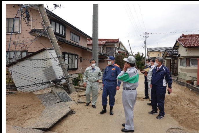
液状化被害を受けた西荒屋地区 3
