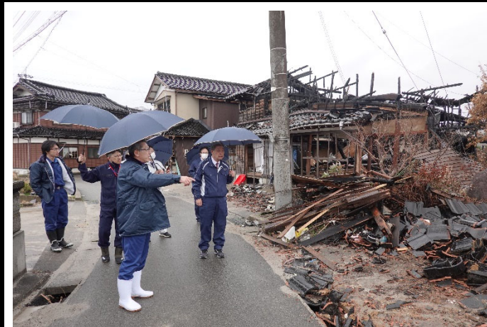
津波被害が発生した白丸地区 3
