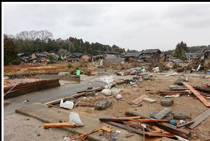
津波被害が発生した白丸地区 5
