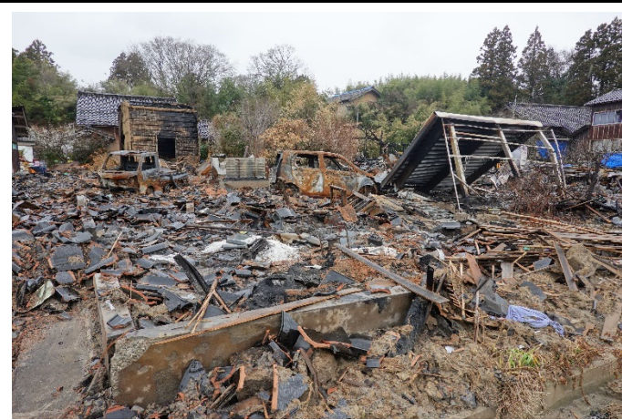
津波被害が発生した白丸地区 4
