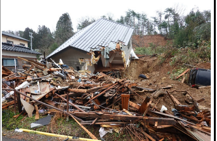
土砂崩れ被害が発生した由比ヶ丘地区4
