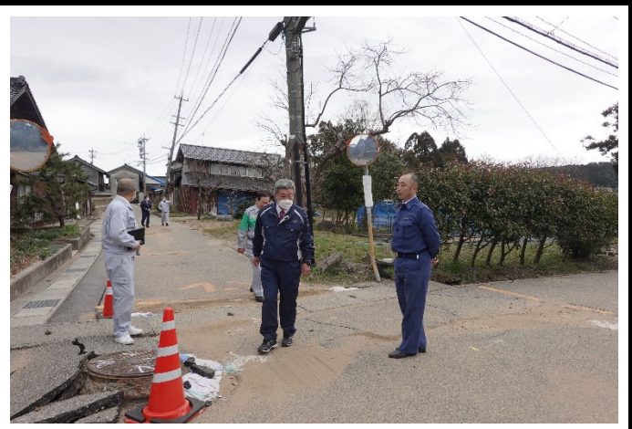
液状化被害を受けた柳瀬地区 6
