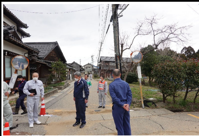
液状化被害を受けた柳瀬地区 5
