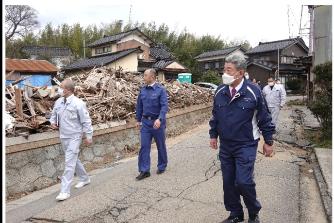
液状化被害を受けた柳瀬地区 3
