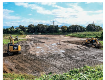
▲令和4年度から2年計画で工事を進めている垂直避難拠点。国土交通省と協力している事業で、河道掘削の土を利用している
