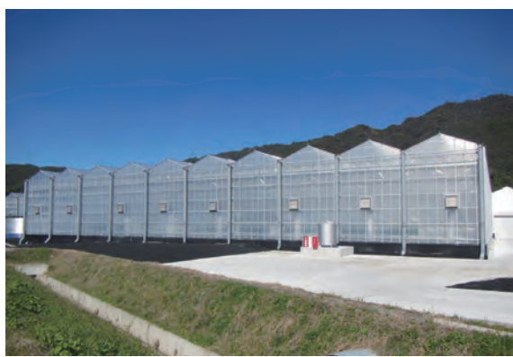
▲次世代型ハウス外観
