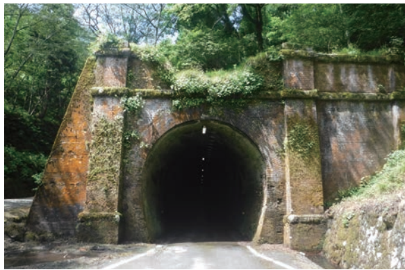
▲旧北陸線 山中トンネル
