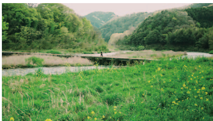
▲木津川を横断している「恋路橋(潜没橋)」
