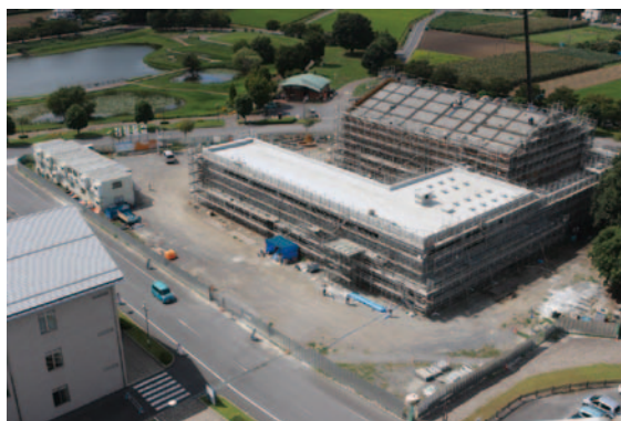
△来年のオープンに向けて建設中の中央公民館
