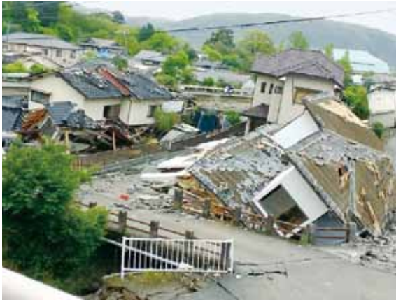
益城町における家屋倒壊の状況 (高松市消防局提供)
