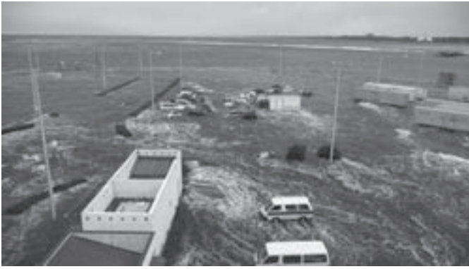
△東日本大震災でのフェリーターミナル津波被害状況
