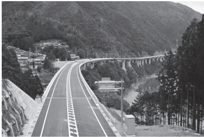
△国道168号の七色高架橋
