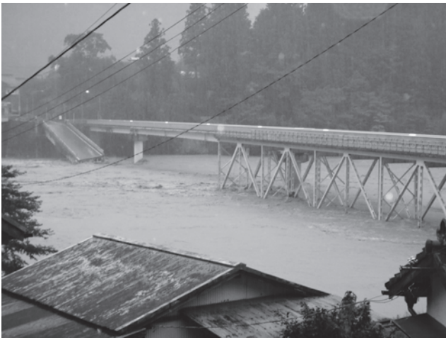
△落橋した折立橋
