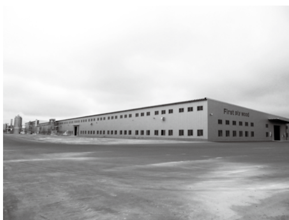
△六戸町金矢工業団地に建設された大型木材加工場
