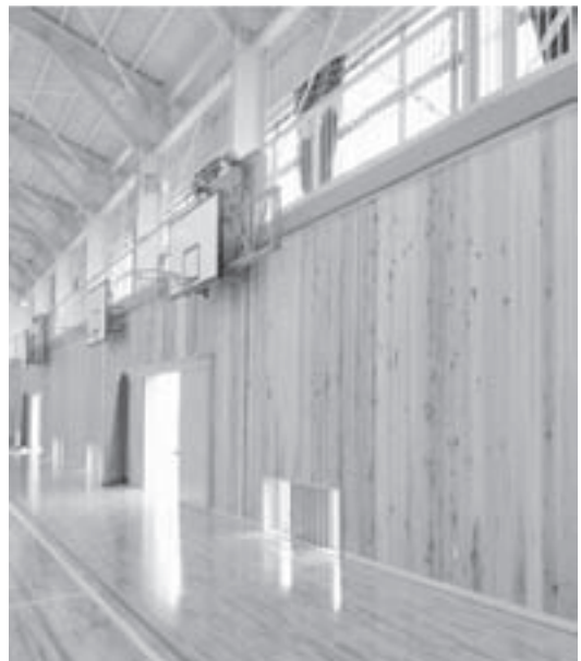
◁ときがわ産材で生まれ変わった、都幾川中学校体育館
