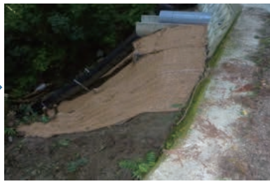
植生マット設置後
