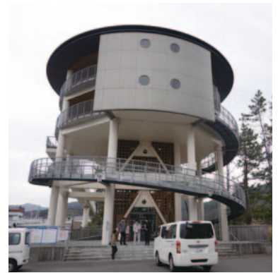
▲津波避難タワー
