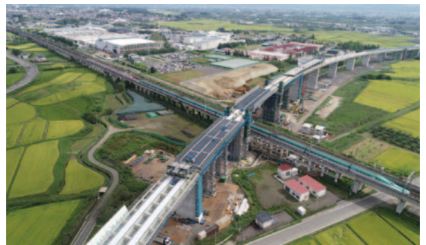
▲東北新幹線の上を通過する東北中央自動車道（相馬福島道路）の本町区間の工事の様子（H30.9月）
