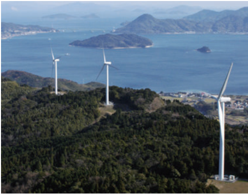
△「室津半島」の山稜に連なる風力発電施設
