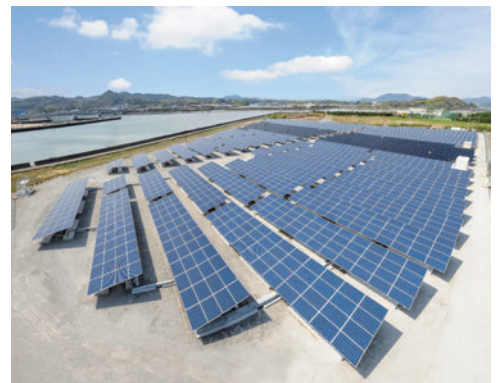
△メガソーラー（太陽光発電施設）
