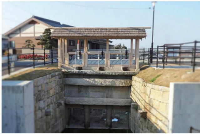
◁移築復元された「土手町南蛭樋」
