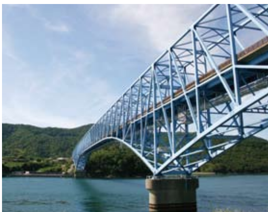
▶南の玄関口、黒之瀬戸大橋
