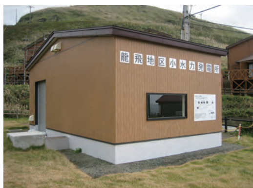
▲龍飛地区小水力発電所
