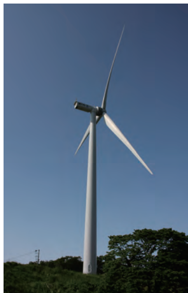
▶(株)津軽半島エコエネの風力発電機
