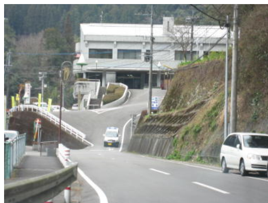
川岸付近の傾斜地にある村役場
