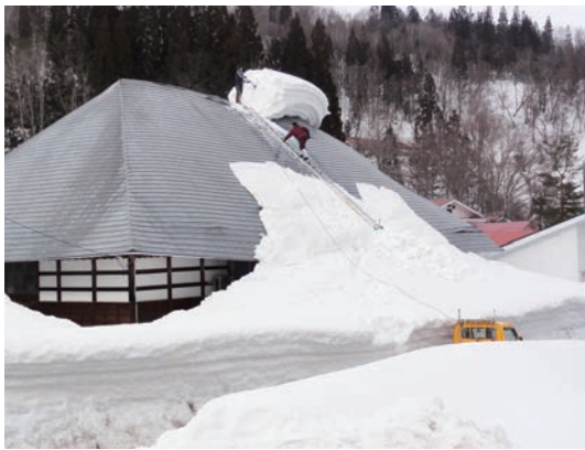
▲空き家となった住宅の危険な雪下ろし作業
