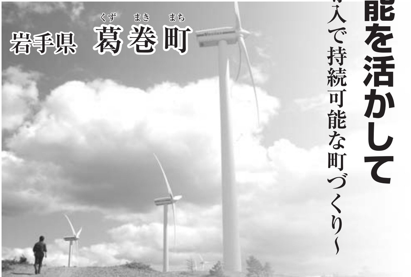
△グリーンパワーくずまき風力発電所の風車は約15000世帯分の消費電力を生み出す。
