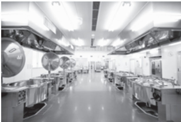
▷オール電化の厨房設備
