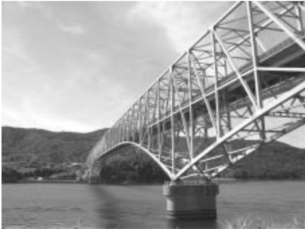
南の玄関口、黒之瀬戸大橋
