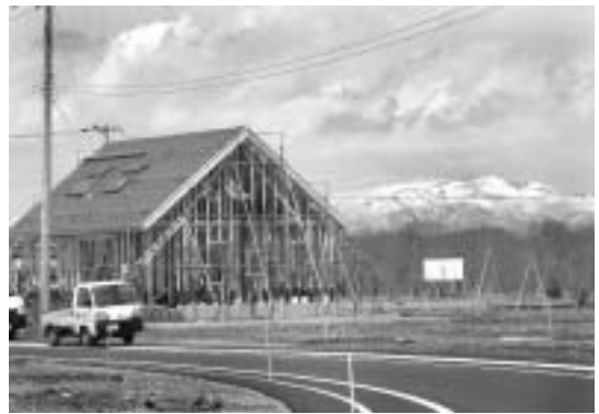
団地第1号の住宅建設の様子
