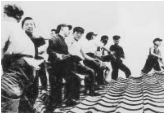
屋根瓦リレー
