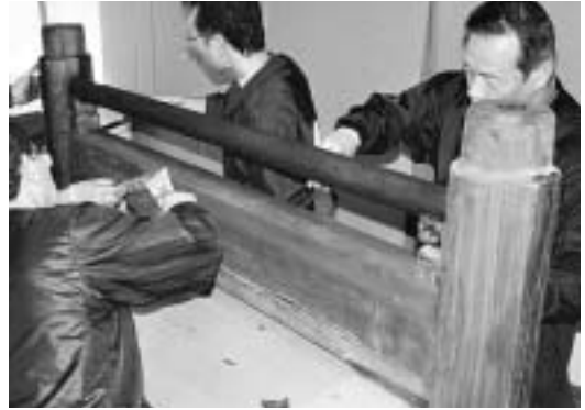
文化財修復事業(安芸富島高舞台)
