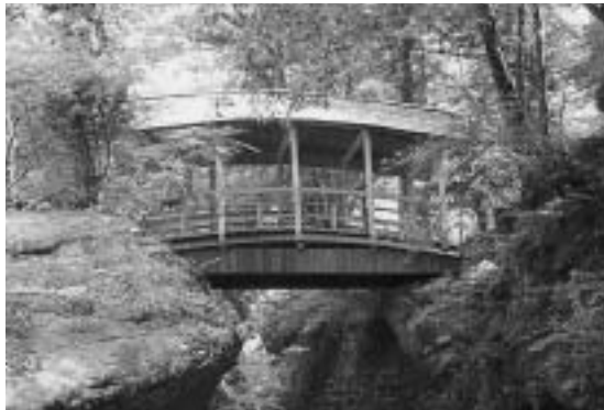
屋根付き橋「御幸の橋」
