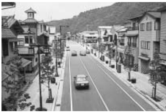
電線類を地中化し、整備されたしょうにん通り
