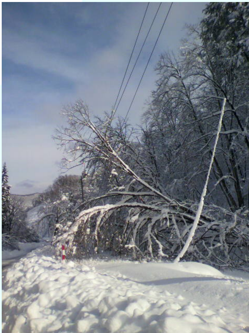
岩手県一戸町 2010.12.31 雪の重みで倒れた樹木が電線に絡まった状況その3
