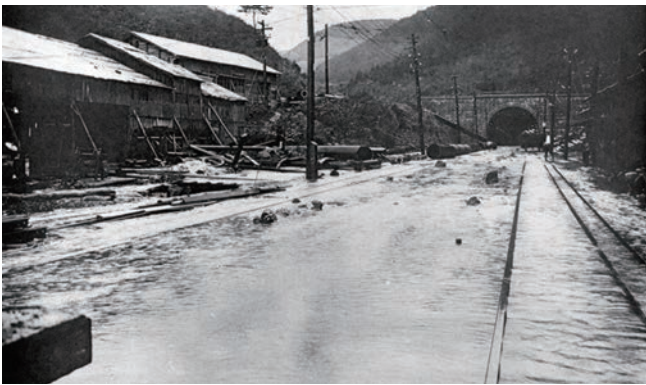
▲建設中の丹那トンネル
