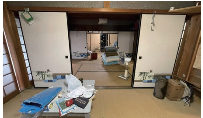
▲空き家改修前
