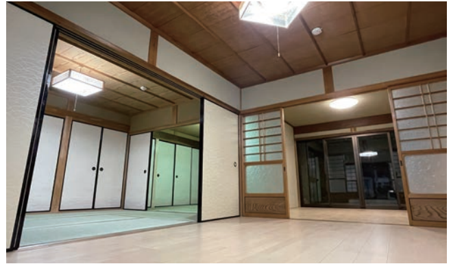
▲昔、土間だった所を改めて土間として復活した。(林業従事者住宅・移住定住促進住宅 空き家改修後)和室(畳)であった所をフローリングに変更
