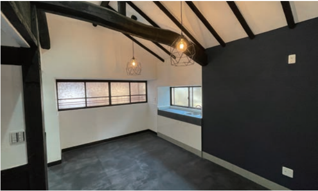
▲昔、土間だった所を改めて土間として復活した。(林業従事者住宅・移住定住促進住宅 空き家改修後)和室(畳)であった所をフローリングに変更
