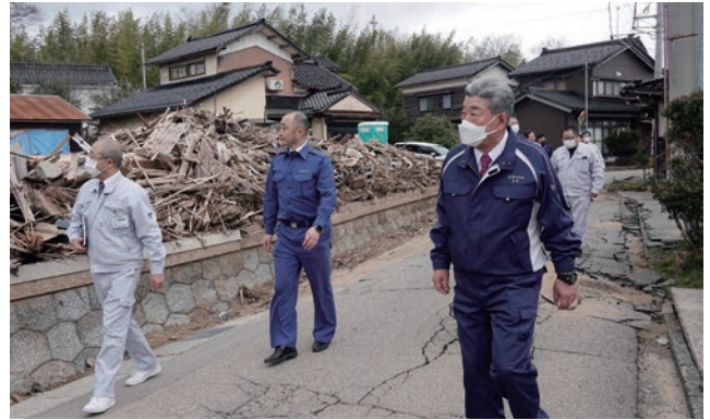
宝達志水町 液状化被害の現場を視察
