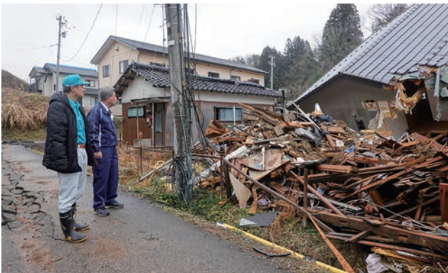
穴水町 土砂崩れの現場を視察
