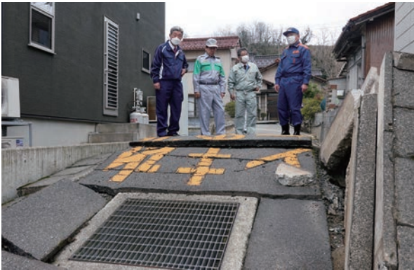
内灘町 液状化被害の現場を視察
