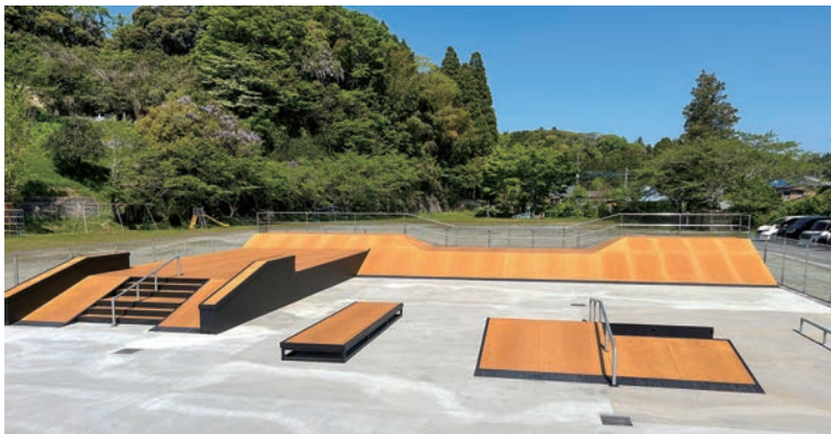
▲「旧長南小学校」(上)は、IT交流施設「長南集学校」としてPCやスマホの無料相談等を行うほか、スケートパーク(下)も整備され、町内外の方々の交流の場となっている
