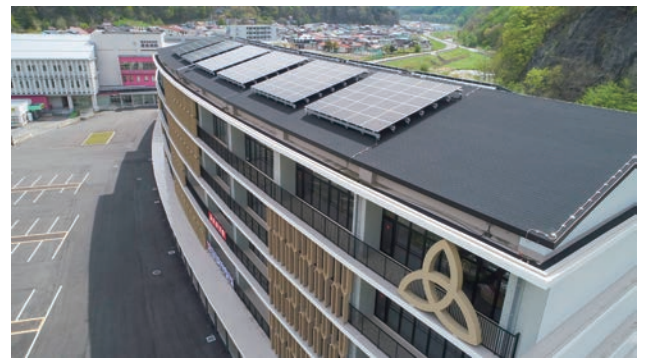
▲複合庁舎「くずま〜る」は太陽光発電等の環境配慮が施されている
