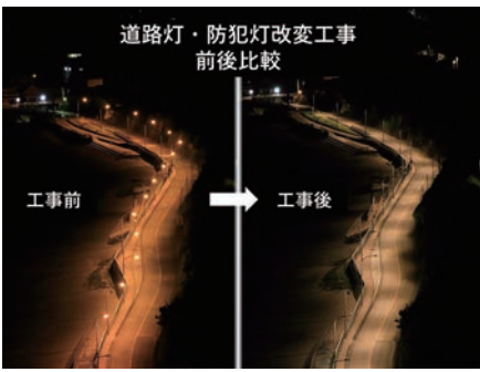
▲光害を防止し、美しい星空を保護するため、道路灯・防犯灯の交換工事を実施。民間企業と協力し、灯具開発から行った
