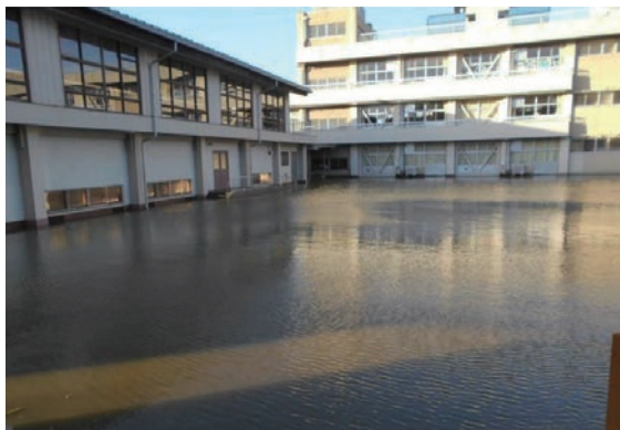
▲浸水被害を受けた校庭
