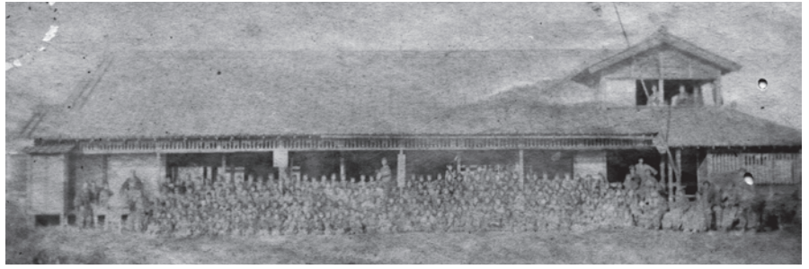
▲③明治5年に撮影された藩校「学習館」全景写真
