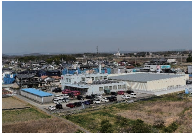
旧加古村役場跡周辺地区内の既存郵便局周辺で住宅や店舗等の形成が進んでいる様子
