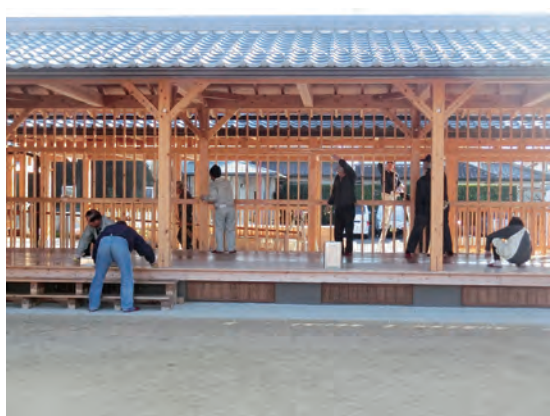
▶園舎の油拭き 地域の皆さんに園舎の柱や床・壁の油拭きをお手伝いしていただいているところ。
