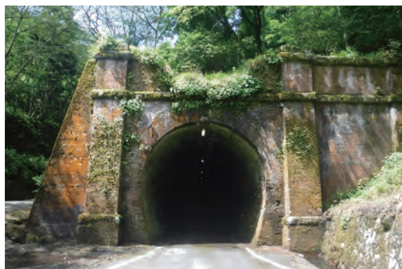
▲旧北陸線 山中トンネル
