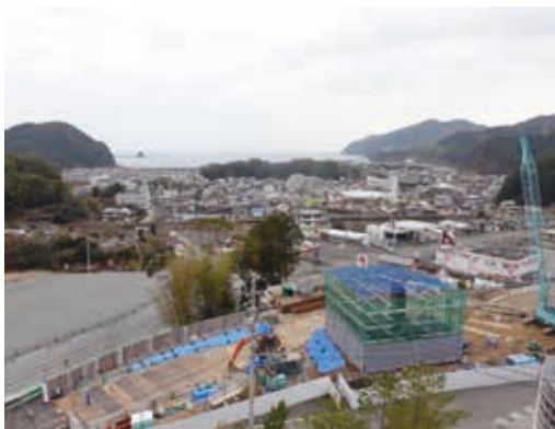
▲工事が進む移転地区
