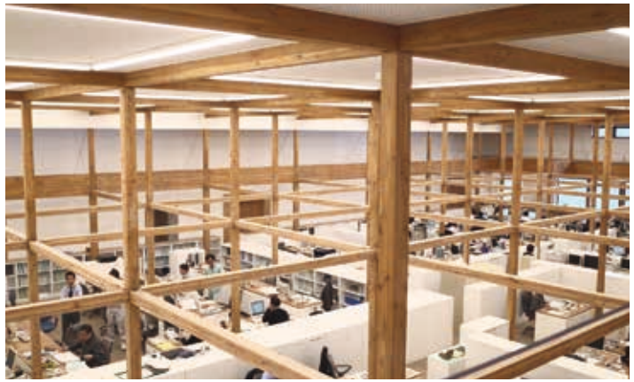
◀町産木材を100%使用した木造の「役場新庁舎」
