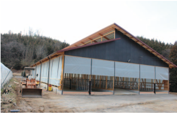
▲チャレンジ基金の支援により建設した牛舎
