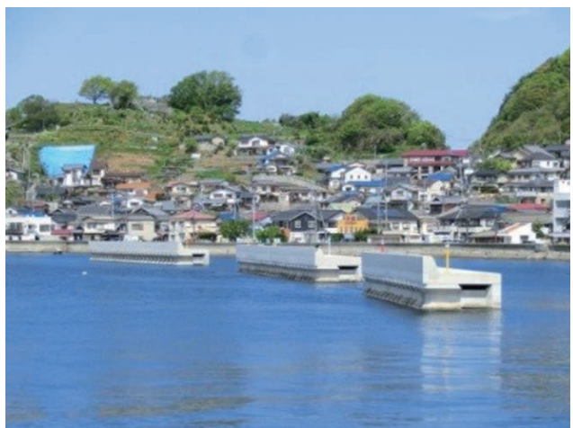
建設された3基の離岸堤
