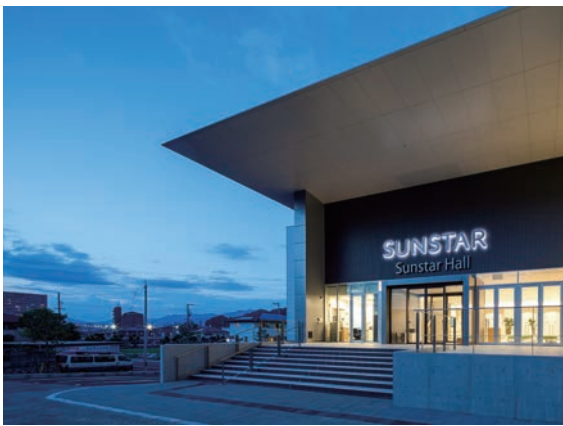
平成26年9月、防災とスポーツ・文化活動の新しい拠点「サンスターホール」が誕生
