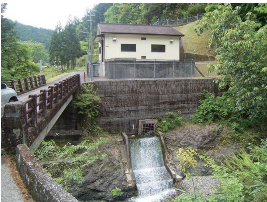
発電所全景と放水口
