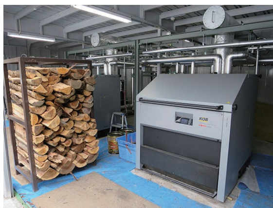
「薪ボイラー」これまでは、山に残されていた残材も立派な村の資源です。
