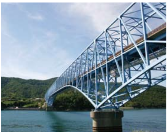
▶南の玄関口、黒之瀬戸大橋
