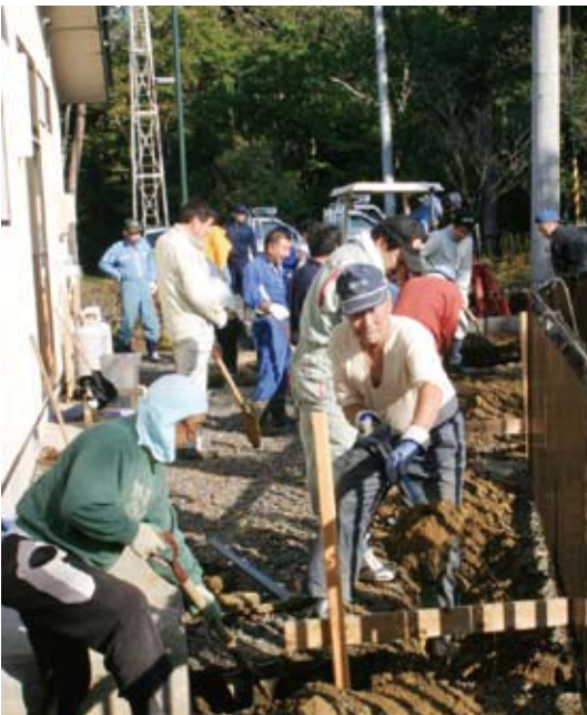
▶共同作業による集会所増築の基礎工事
