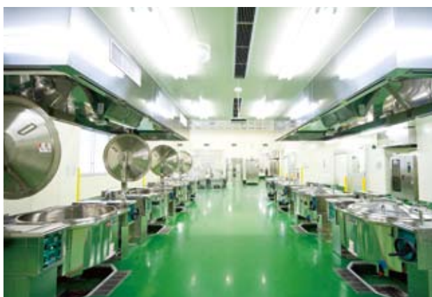
▶オール電化の厨房設備
