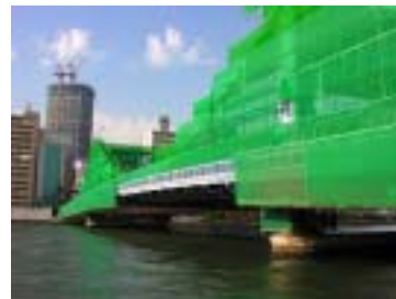
橋りょうの補修
