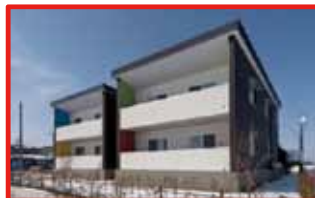
福島県CLT推進協議会 集合住宅(H27.2竣工) 福島県湯川村 2階建て・2棟
