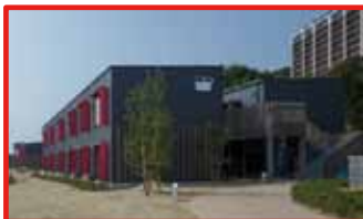
ハウステンボス ホテル(H28.2竣工) 長崎県佐世保市 2階建て・6棟
