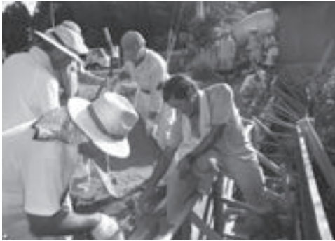
▶ 資材・重機借り上げにかかる費用を町が負担し、住民ボランティアで道路を整備する「ジゲ(地元)の道づくり」事業(あいま手間山地域振興協議会)
